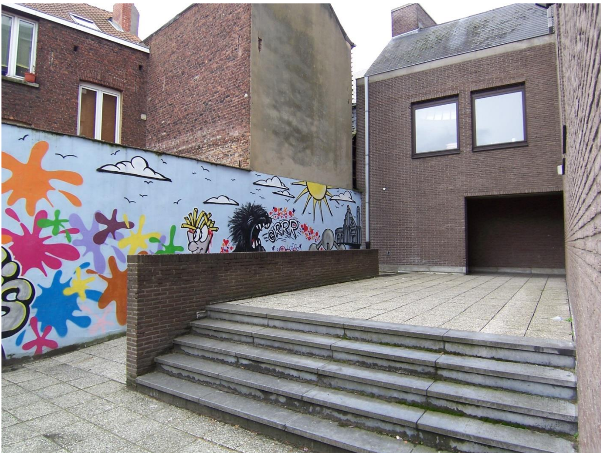
foto 2: achterzijde van de "Villa", hoogteverschil tussen de Jan De Greefstraat en de speelplaats duidelijk zichtbaar
