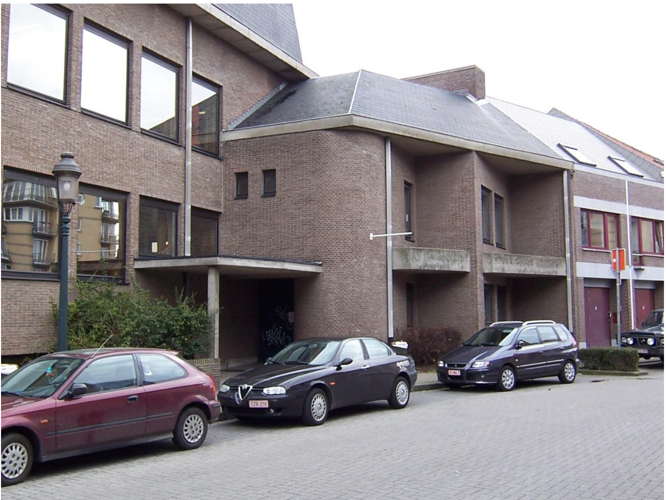
foto 4: straatgevel van het "blok B" en de "Villa" in de Jan De Greefstraat.
