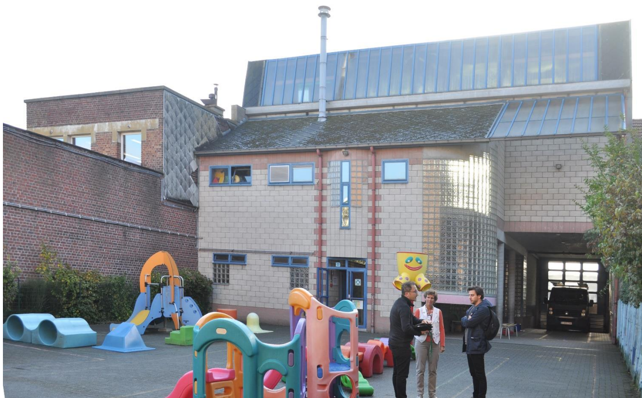
foto 7: achtergevel van het bestaande turnzaalgebouw en de bestaande onderdoorgang (4m hoog en 4m breed).
