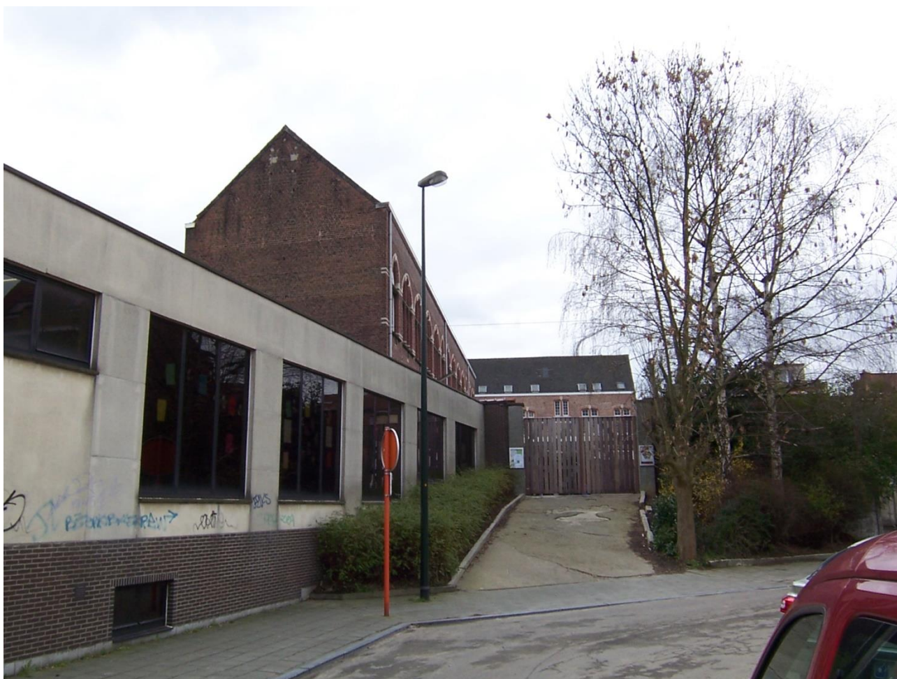
foto 5: achtergevel van het "blok C" en de bestaande schoolpoort in de Opvoedingsstraat
