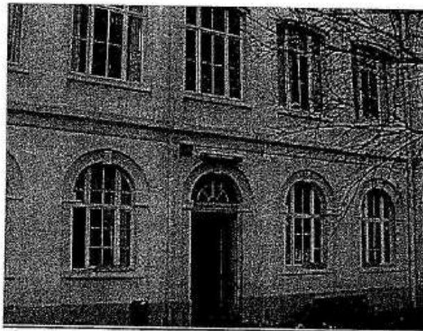
Photo 5 Bâtiment central école 7
