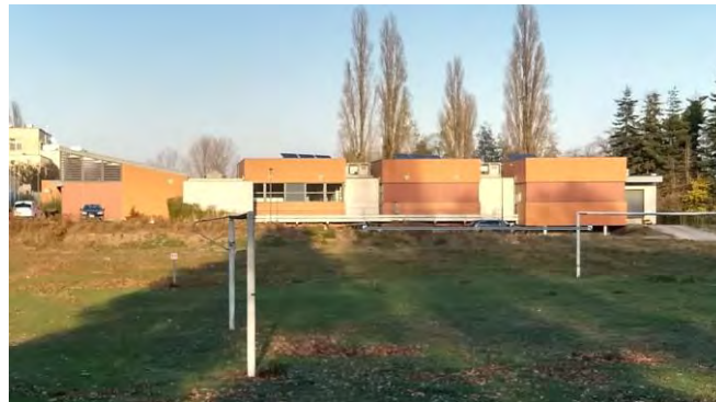
Figure 49 : Vue du centre de Technologies Avancées depuis le Sentier de la Drève (ARIES, 2018)
