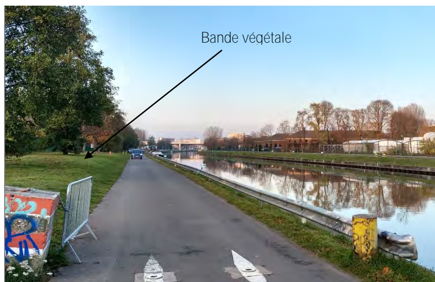
Figure 66 : Vue du Quai de Veeweyde (ARIES, 2018)
