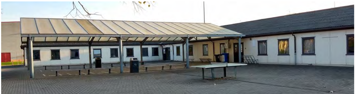
Figure 60 : Vue 3, Bâtiment et espace minéral côté drève (ARIES, 2018)
