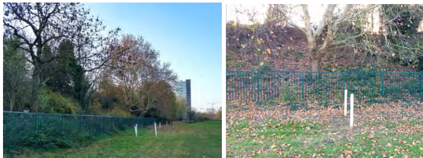
Figure 65 : Vue du talus le long du Ring (ARIES, 2018)
