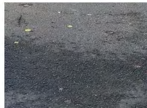
Asphalte du Sentier de la Drève
