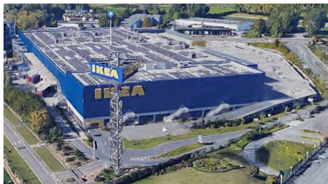
Figure 50 : Vue du bâtiment IKEA de l'autre côté du Ring (Google Earth, 2018)
