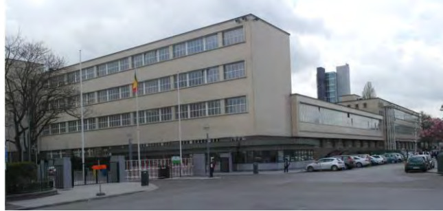
Figure 39 : Bâtiments sis Avenue Emile Gryson repris à l'inventaire (Irismonument, 2016)
