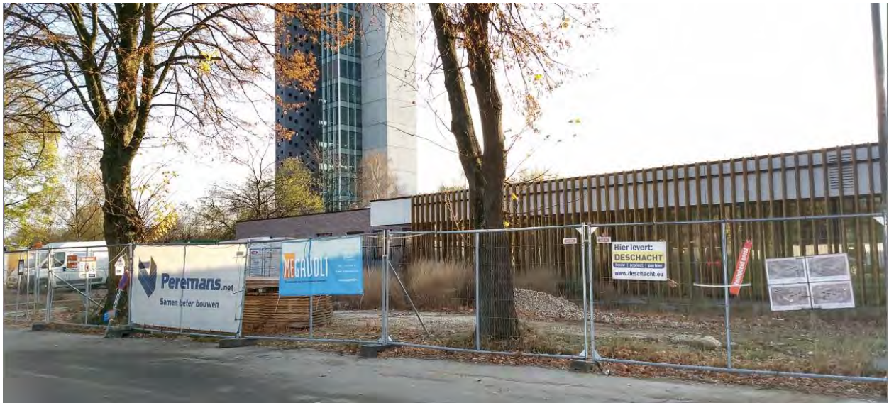
Figure 71 : Etat d'avancement du chantier en cours à l'Ouest du site (ARIES, 2018)
