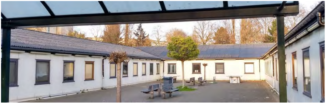
Figure 58 : Vue 1, Bâtiment et espace minéral côté intérieur du site (ARIES, 2018)
