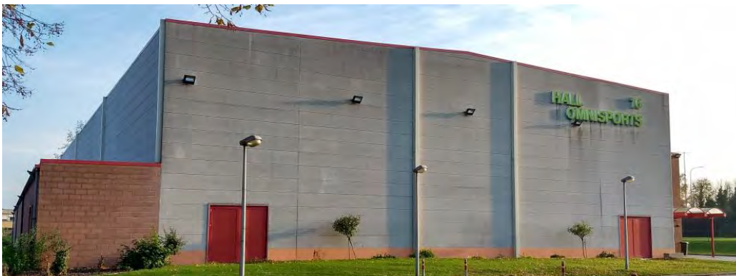
Figure 62 : Vue de la façade Ouest du bâtiment (ARIES, 2018)
