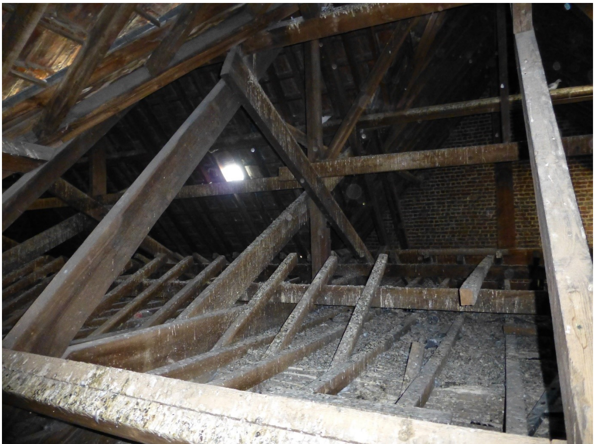
32. Sous-toiture bâtiment J
