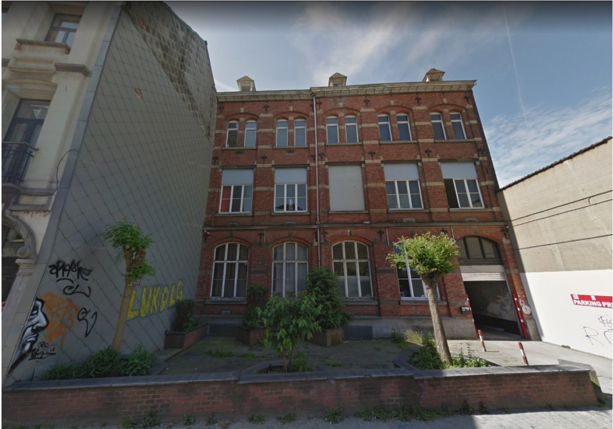
01. Façade à chaussée Boondael
