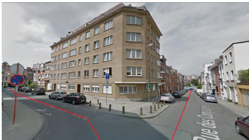
Angle - de la Rue des Compagnons/ Rue Louis Socquet
