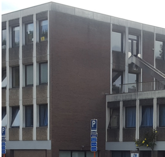
Teintes bâtiment existant
