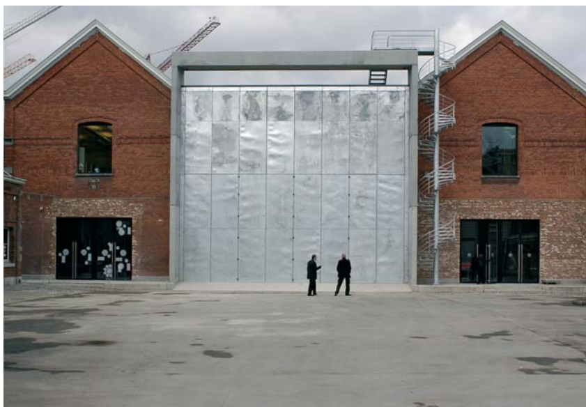
La Maison Folie est une réalisation de l'Atelier d'Architecture Matador, qui a su enrichir le programme du lieu tout en respectant les contraintes budgétaires, au bénéfice des maîtres d'ouvrage, la Communauté française et la Ville de Mons.
