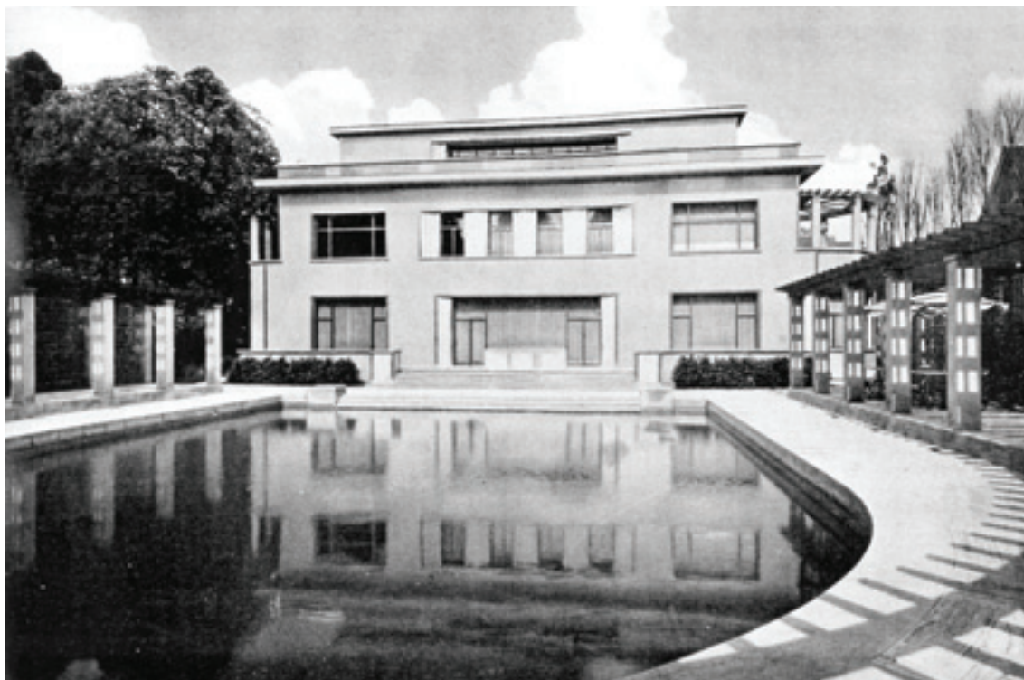
Restauration de la «Villa Empain» (Ville de Bruxelles) pour y aménager, notamment, le Musée de l'Orient - Permis unique délivré en novembre 2008 - Photo issue des Archives de la Fondation Boghossian.
