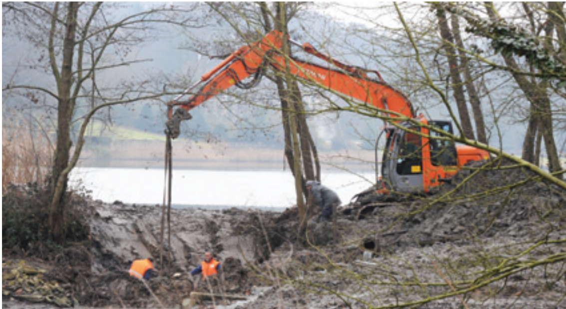
Rénovation du système hydraulique du complexe des étangs de Val Duchesse, Mellaerts et Parmentier (WSL) - PU délivré en mai 2008 avec rapport d'incidences.
