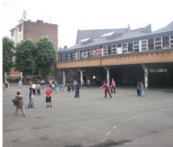
CQ Saint-Antoine - Ecole 11b et 9, rue du Montenegro.
