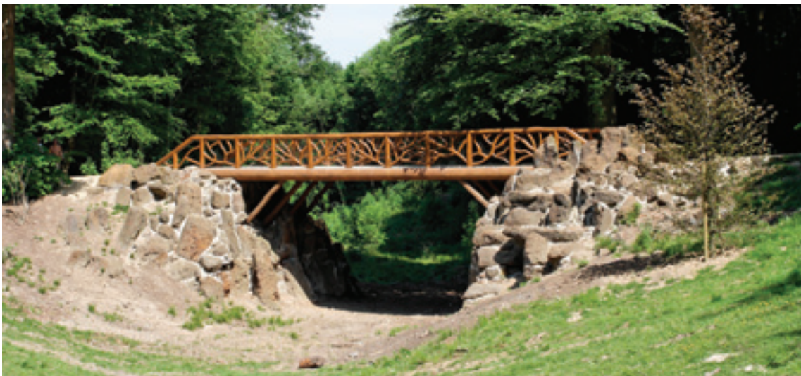
Reconstruction du Pont du Diable au Bois de la Cambre, dans le cadre des accords Beliris.
