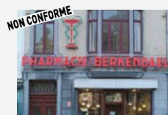
Enseigne parallèle non conforme située à moins de 0,50 m des limites mitoyennes.
