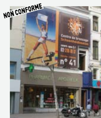
Dispositif de publicité non conforme, nuisant à l'habitabilité en masquant les baies.
