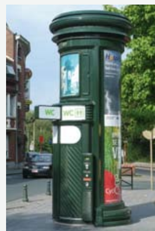
Colonne porte-affiches conforme, répondant aux conditions de l'article 27.
