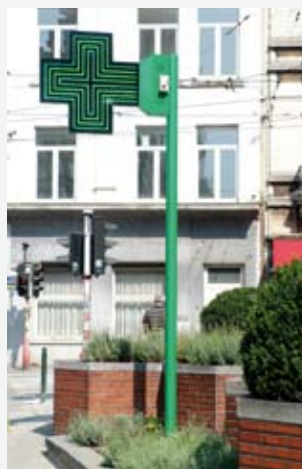
Enseigne scellée au sol conforme, répondant aux conditions de l'article 39.
