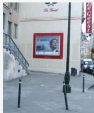
Dispositif de publicité sur pignon conforme, répondant aux conditions de l'article 12.
