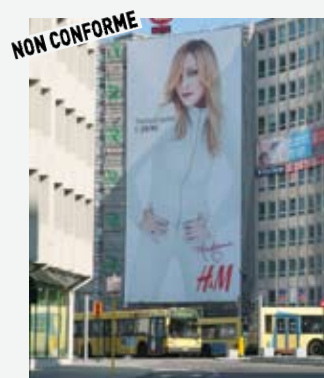
Publicité sur bâche de chantier non conforme car la limite supérieure de celle-ci est supérieure à 12 m par rapport au sol.
