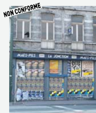
Publicités non conformes car la publicité est interdite sur les immeubles inoccupés ou inexploités.
