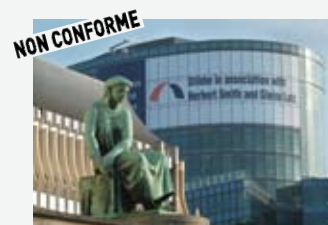
Vinyle publicitaire non conforme car la limite supérieure de celui-ci est supérieure à 12 m par rapport au sol.
