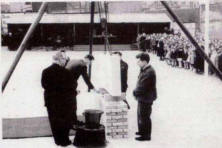
De onteigeningen en de werken liepen van in het begin vertraging op. De eerste steenlegging vond uiteindelijk plaats op 21 april 1958. [Foto uit Thierry DEMEY, Bruxelles Chronique d'une capitale en chantier , Paul Legrain, Brussel, 1992.]
