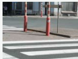
Conforme oversteek van een verkeerseiland.
