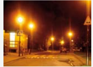
Verlichting van de snelheidsbeperkende inrichting en haar signalisatie.
