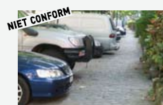
Niet-conforme bescherming van het trottoir.
