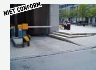
Niet-conforme berijdbare oprit, daar deze niet in overeenkomst is met § 2.
