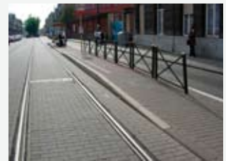
Toegangshelling van een halte van het openbaar vervoer.
