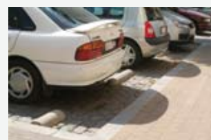
Conforme bescherming van het trottoir.
