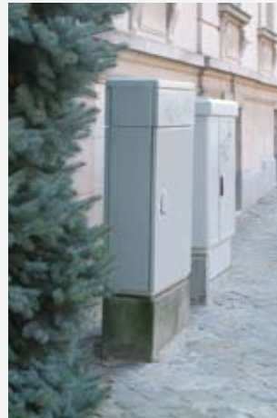
Conforme plaatsing van de kasten van de concessiehouders.
