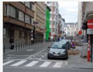
Opstelstrook en vooruitgeschoven zone in een éénrichtingsstraat.
