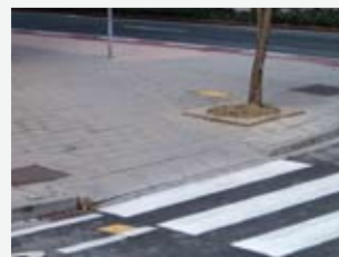
Oversteekplaats voor voetgangers met een geleidelijke verlaging.
