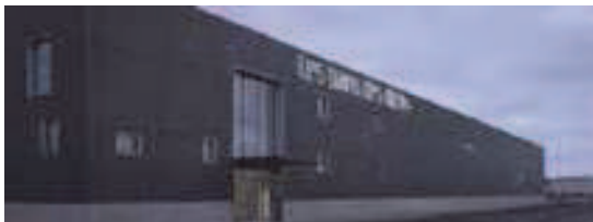
Les bains des docks, Le Havre
