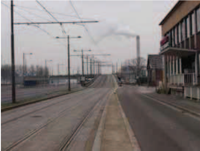
De toegangshellingen van de Van Praet Brug zijn ruimtelijk en visueel omvangrijk. Van ver zijn de schoorsteen en rookpluimen van de verbrandingsoven sterk aanwezig zijn.
