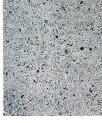
exemple de béton désactivé
