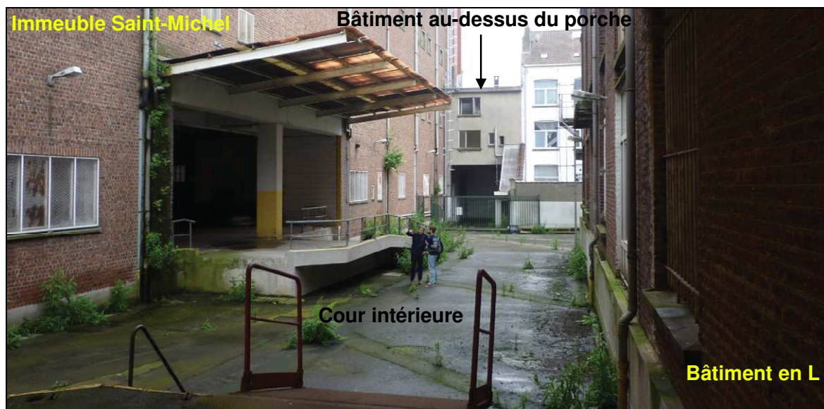
Photo 1 : Vue du site depuis la cour intérieure - immeuble Saint-Michel à gauche, porche d'accès à la cour intérieure au milieu et bâtiment en L à droite
