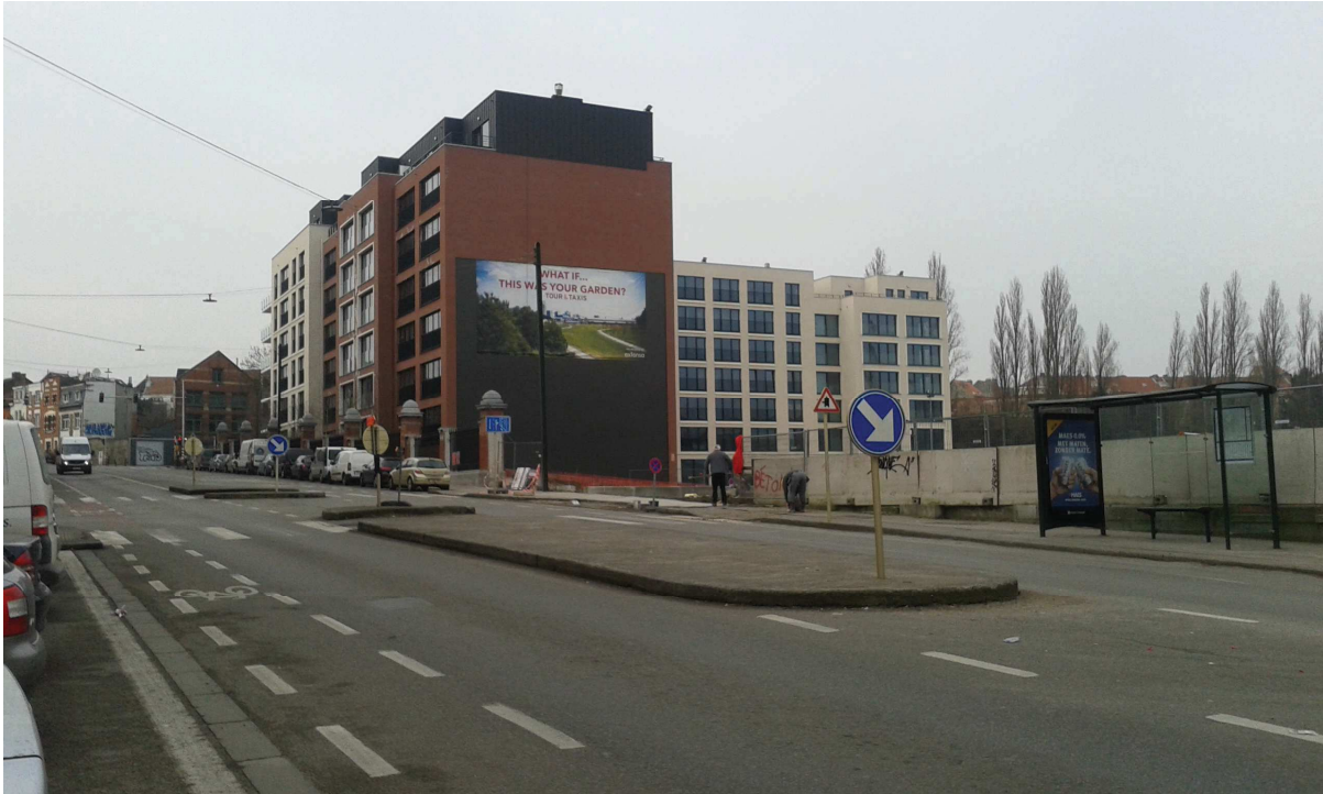
Photo 7 : Vue depuis la toiture de l'immeuble St-Michel vers l'immeuble de logements en cours de construction sur le site de Tour et Taxis (Septembre 2016)
