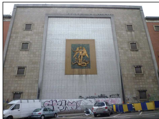
Photo 16 : Façade de l'immeuble côté Picard
