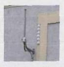
Les antennes de micro-cellules sont utilisées dans une zone à forte densité d'usagers, par exemple dans une gare, une rue très fréquentée. Elles sont typiquement placées sur la façade d'un bâtiment. Elles ont une
