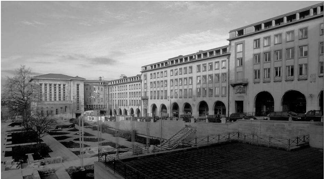
Figure 30 : Immeuble du Mont des Arts
