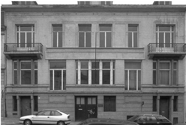
Rue du Cornet 43-45 – 1040 Bruxelles Immeuble de bureaux transformé en crèche.
