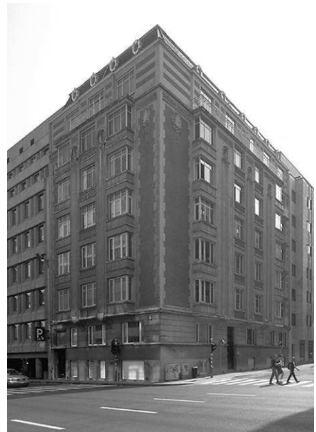
Rue de la Loi 81 A Immeuble de bureaux convertis en Hôtel
