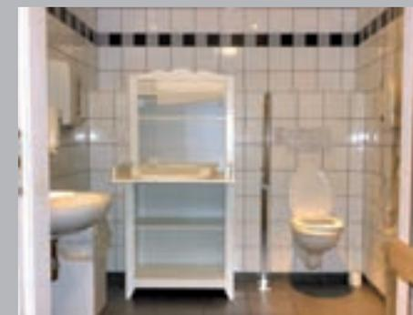
✗ Aire de transfert encombrée par table à langer et n'étant pas dans l'axe de la porte
