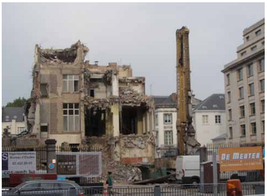
Coin Régent / Loi (Bruxelles) Le permis autorise la démolition suivie de la reconstruction d'un immeuble de bureaux, avec extension de la surface tant hors-sol (+ 1.200 m 2 ) que sous-sol (ce qui permet la création d'un parking souterrain). Photos prises en juillet et en octobre 2013.
