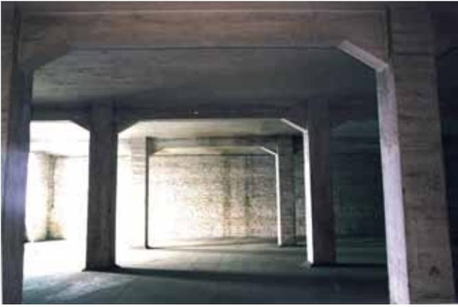
Fig. 7 : Vue sur la structure porteuse en béton armé de l'Entrepôt public B de Tour et Taxis
