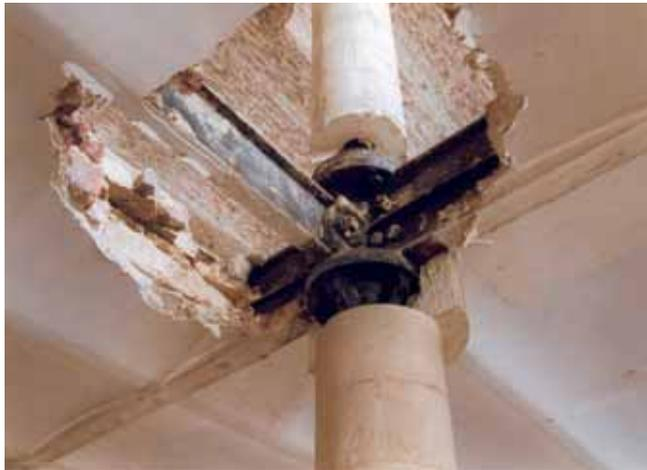
Fig. 3 : Structure ajourée du plancher léger du Mont-de-Piété bruxellois (1859). Tous les éléments structuraux en fer sont protégés de manière passive. (photo 1998).
