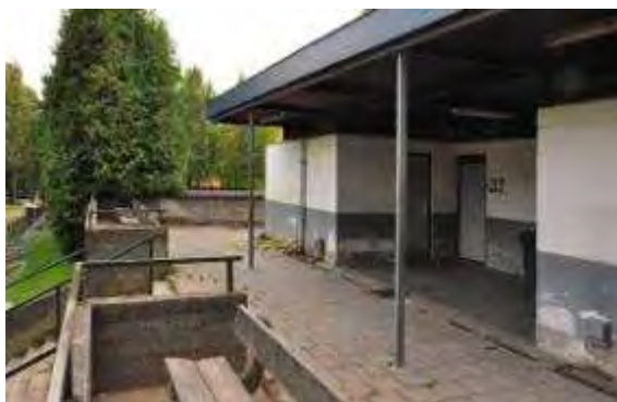
Figure 117 : Vestiaire et sanitaires (APEB, 2011)
