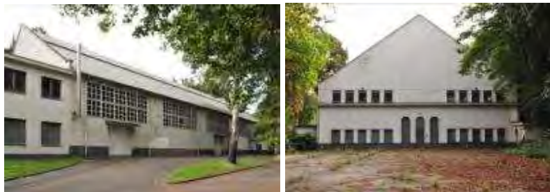
Figure 100 : Façade est et façade pignon nord (APEB, 2011)
