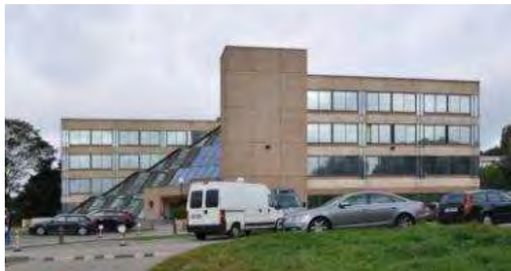
Figure 113 : Bâtiment de l'URBSFA (APEB, 2011)
