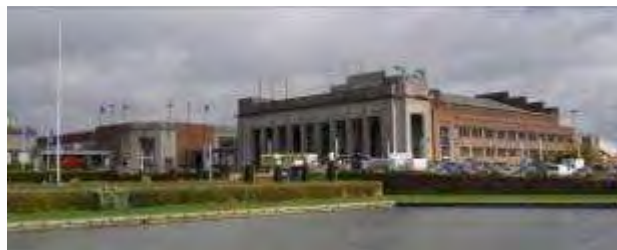
Figure 73 : vue du Palais 6 et 10 (APEB, 2011)
