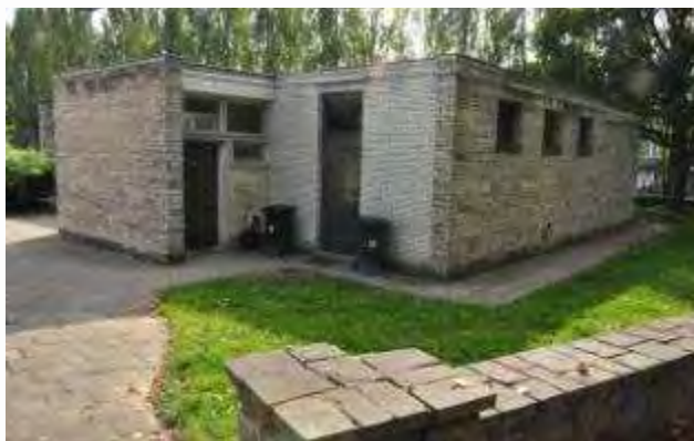
Figure 88 : vestiaire et sanitaires (APEB, 2011)
