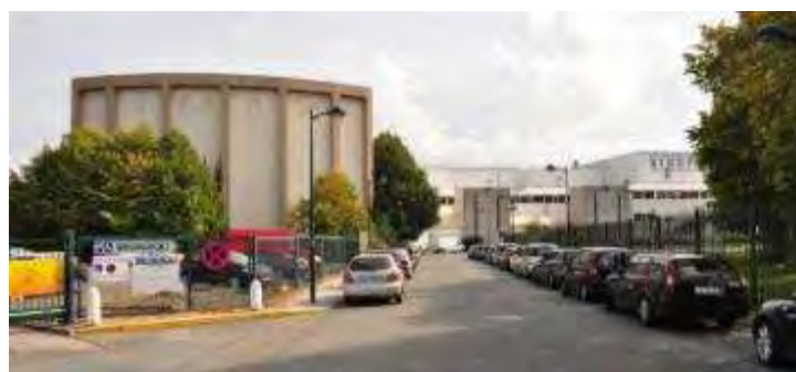
Figure 110 : Vue du Kinépolis depuis l'avenue des Athlètes (APEB, 2011)
