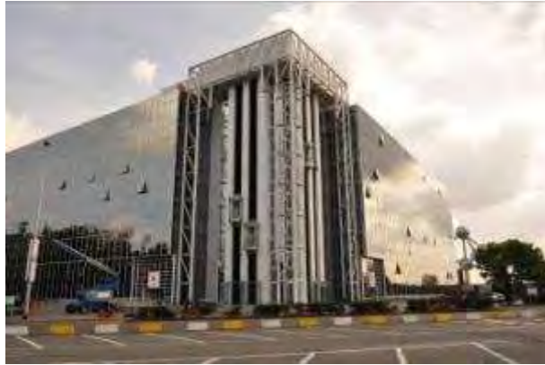
Figure 98 : Façade principale de l'immeuble (APEB, 2011)
