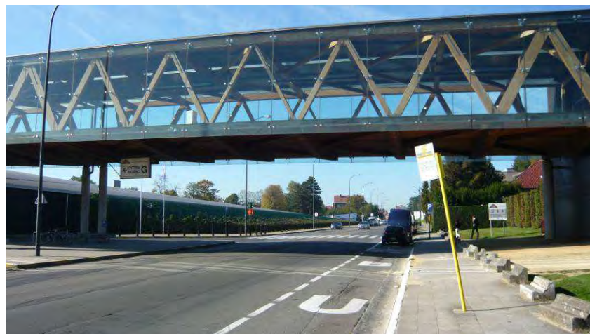
Figure 188 : Vue sur la passerelle (Google StreetView, 2014)
