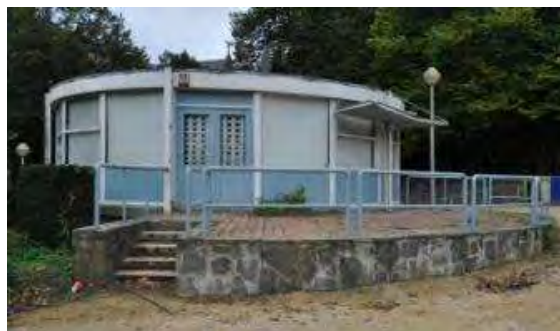
Figure 124 : Bureau de la porte du Benelux (APEB, 2011)
