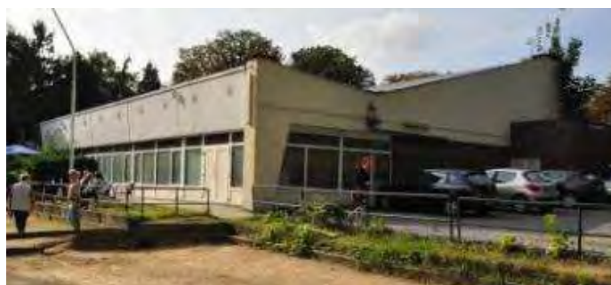
Figure 116 : Bâtiment du Leo Pétanque Club (APEB, 2011)
