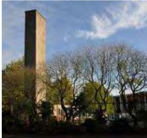
Figure 65 : photo actuelle de la cheminée de la chaufferie (APEB, 2011)
