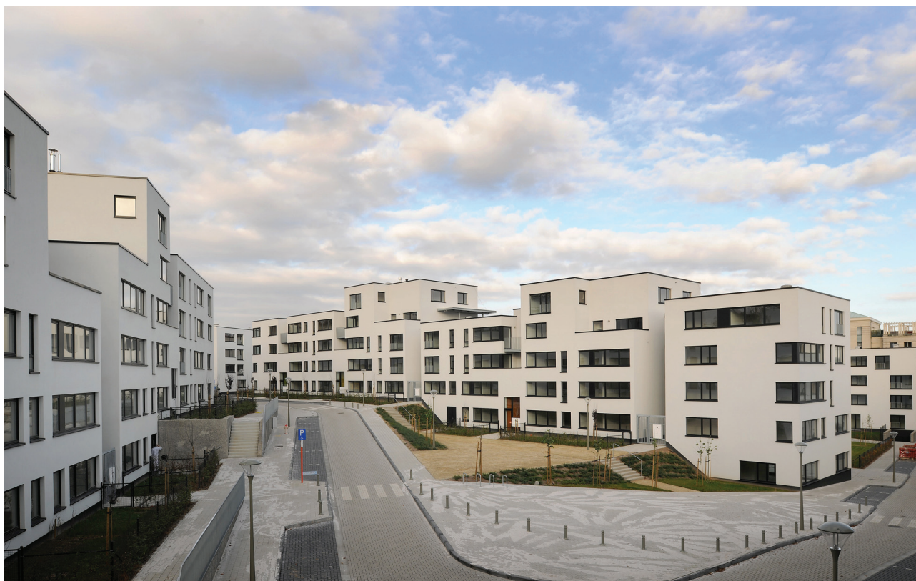
Décembre 2011 : inauguration du projet “Ernotte” à Ixelles. Construction de 316 nouveaux logements (232 sociaux et 84 moyens) dans le cadre du Plan Régional du Logement (Photographe : S. Brison)
