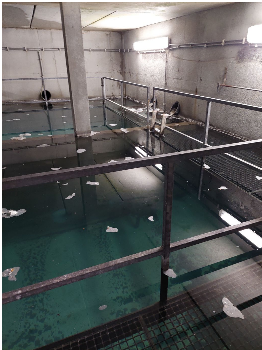
Figure 3 : exemple d'un bassin réserve d'eau sous fontaine
