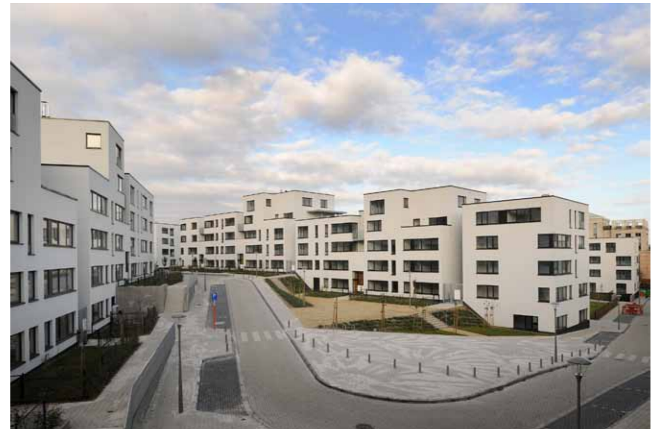
December 2011: inhuldiging van het project 'Ernotte' in Elsenne. Constructie van 316 nieuwe woningen (232 sociale woningen en 84 middelgrote woningen) in het kader van het gewestelijk huisvestingsplan (Fotograaf: S. Brisson)
