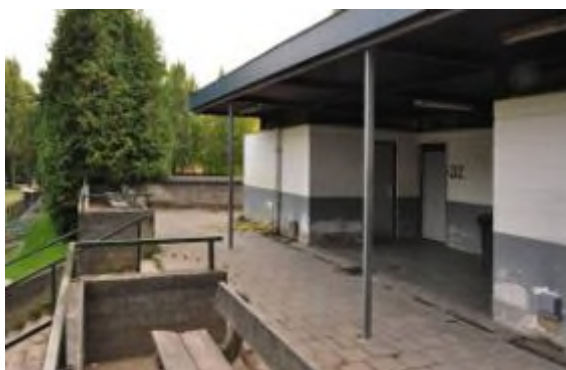
Afbeelding 117: Kleedkamers en sanitair (APEB, 2011)
