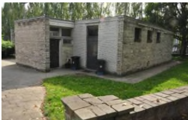
Afbeelding 88: kleedkamers en sanitair (APEB, 2011)
