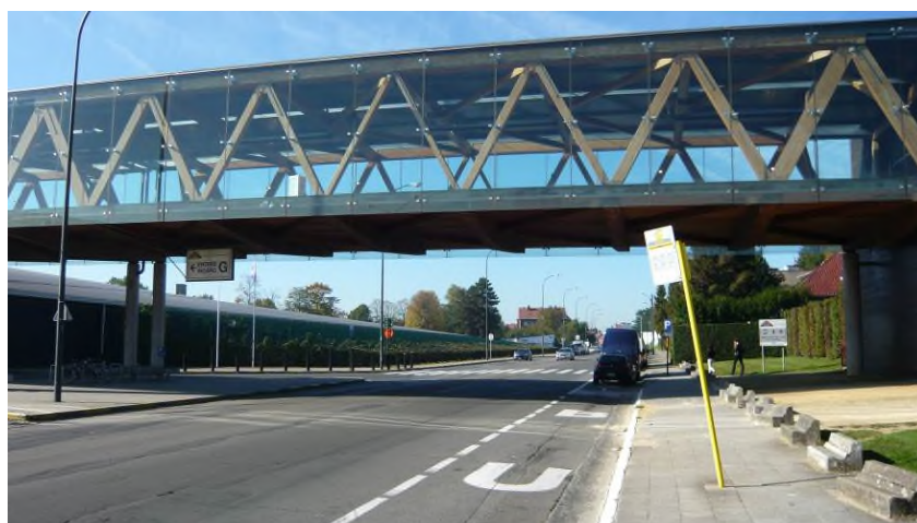
Afbeelding 188: Uitzicht op de brug (Google Street View, 2014)
