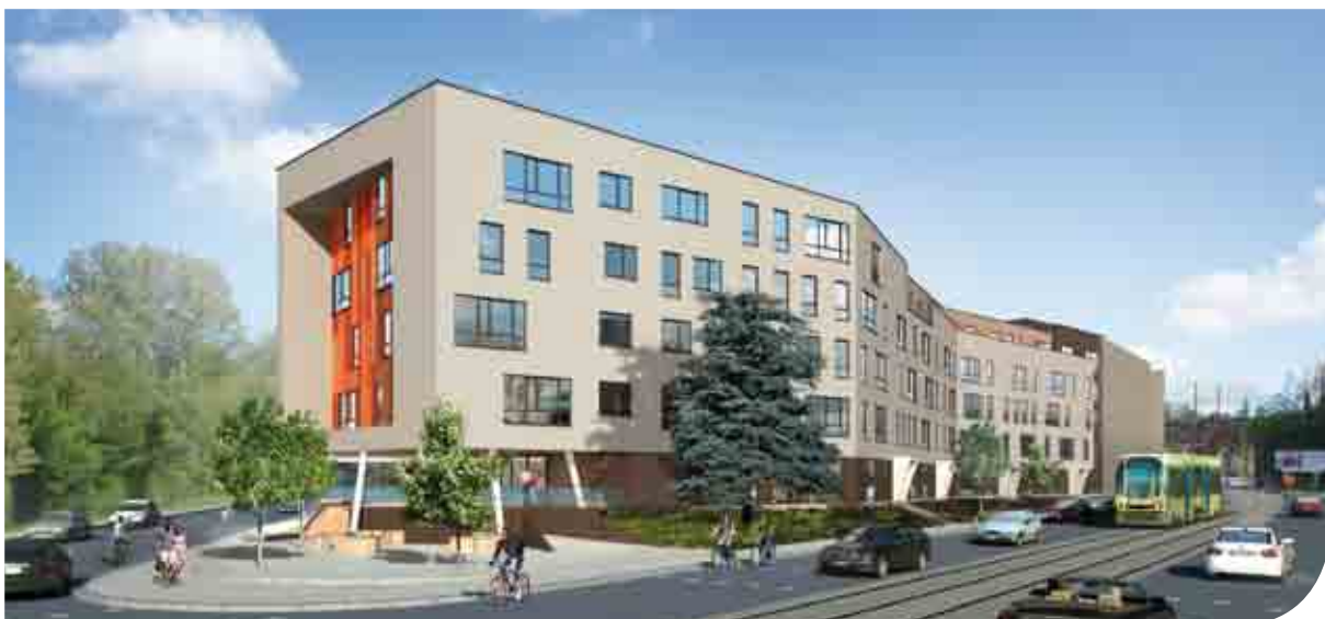
Augustus 2011: afgifte van de stedenbouwkundige vergunning voor het Bourdon-project in Ukkel. Constructie van een geheel van 68 woningen (34 sociale en 34 middelgrote woningen). Start van de werf eveneens in 2011 (Architectenbureau BEAB)
