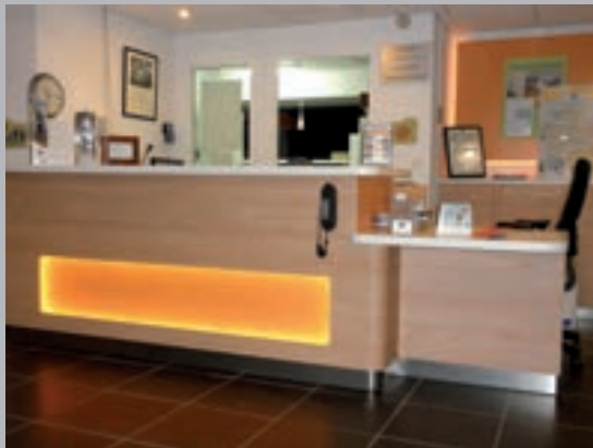
✗ Verlaagd werkblad is niet diep genoeg
