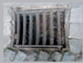
✗ Afvoergoot met gleuven > 2 cm
