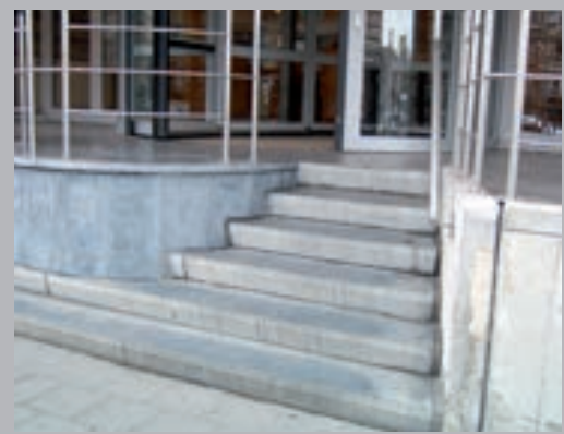
✗ Niet-contrasterende trapneuzen
