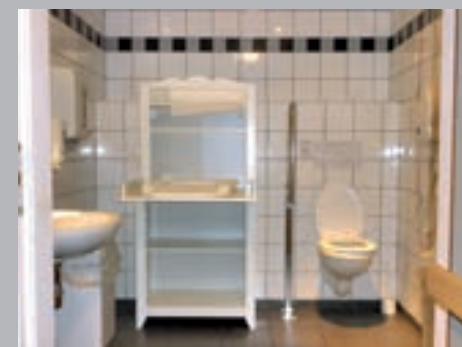
✗ Transferruimte die versperd is door een verzorgingstafel en zich niet in de as van de deur bevindt
