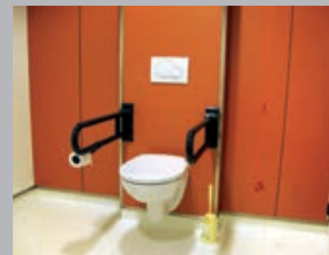
✓ Aangepast toilet met twee transferruimten
