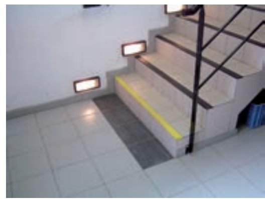
✓ Neus van de eerste trede met geel contrast Neus van de andere treden met zwart contrast
