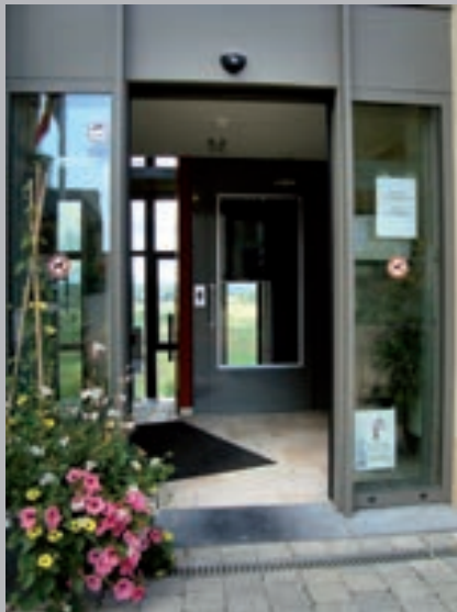
✓ Voldoende brede puntversmalling van de gang
