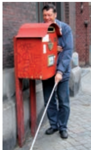
✘ Detectie met blindenstok onmogelijk
