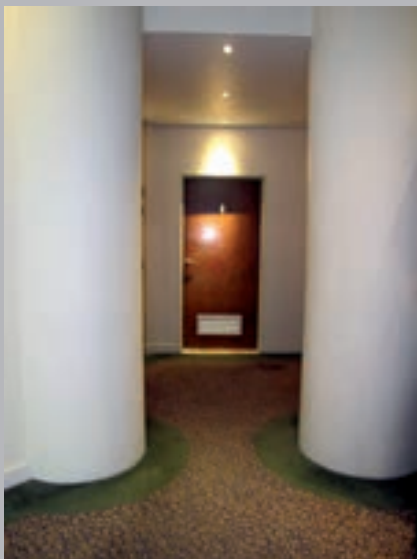
✓ Réduction ponctuelle du couloir de largeur suffisante
