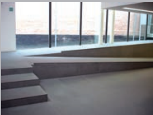
x Begin van de helling is niet beveiligd aan de open zijde
