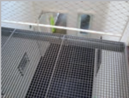
✗ Opengewerkte vloerbedekking
