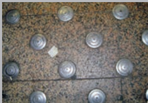
✓ Noppen, te verlijmen of in te gieten
