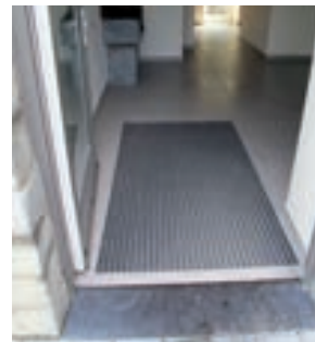
✅ Deurmat ingewerkt in de vloer
