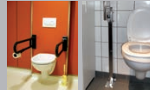
✗ Bevestigingsschoen in de transferzone
